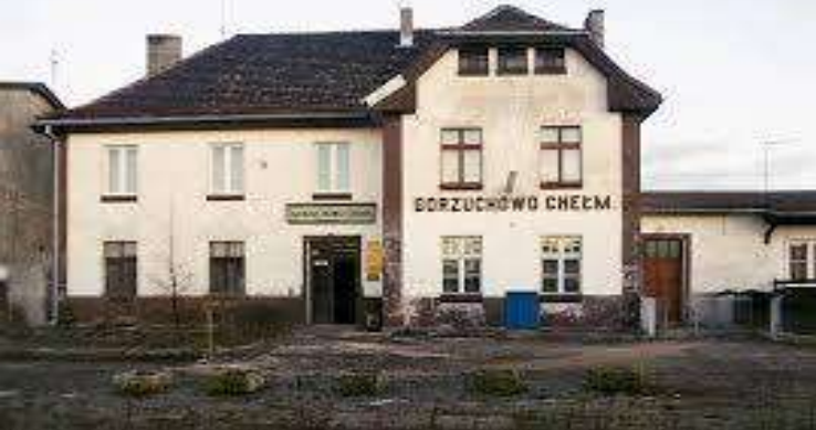
Dworzec kolejowy w Gorzuchowie Chetm.
