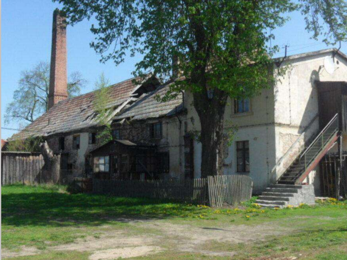
Zrujnowany dom w Rulewie, w którym mieszkała rodzina Malinowskich.
