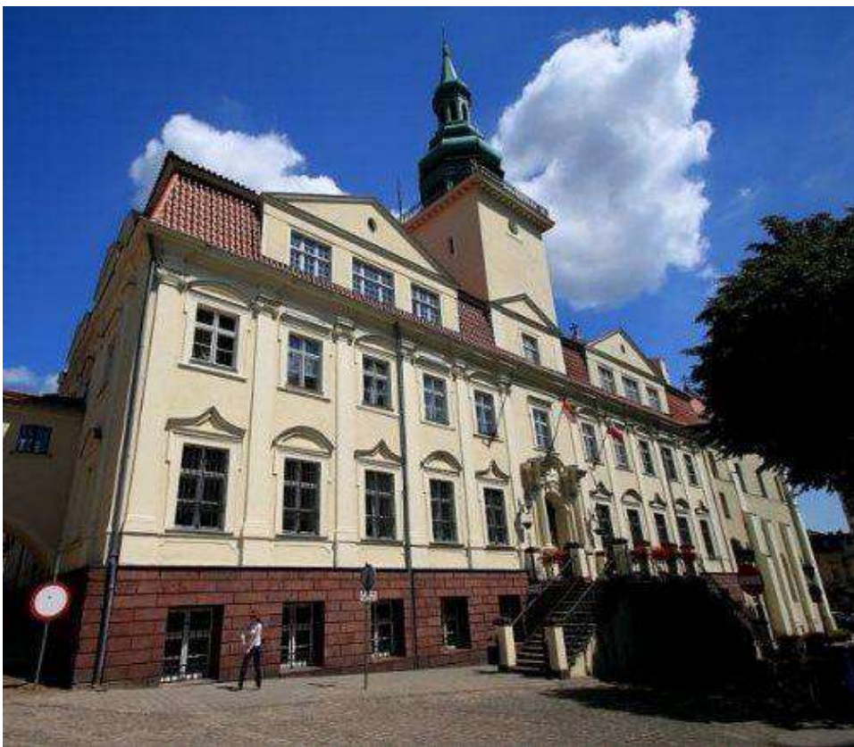
/budynek Urzędu Miejskiego w Grudziądzu/
